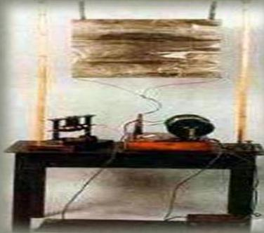
Protótipo construído por Marconi em 1895, uma simples montagem constituída de dois componentes básicos, uma Bobina de Ruhmkorff como emissor e um Coesor como detector desenvolvido em 1890 pelo físico francês Edouard Branly.
